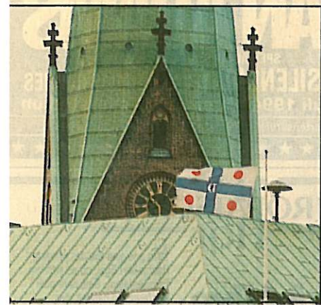
...s der Kupferdächer am Ballindamm, da- ter der Turm von St. Petri. Er wurde 1878 ... Kupfer-Wellblech gedeckt. Foto: ZAPF
