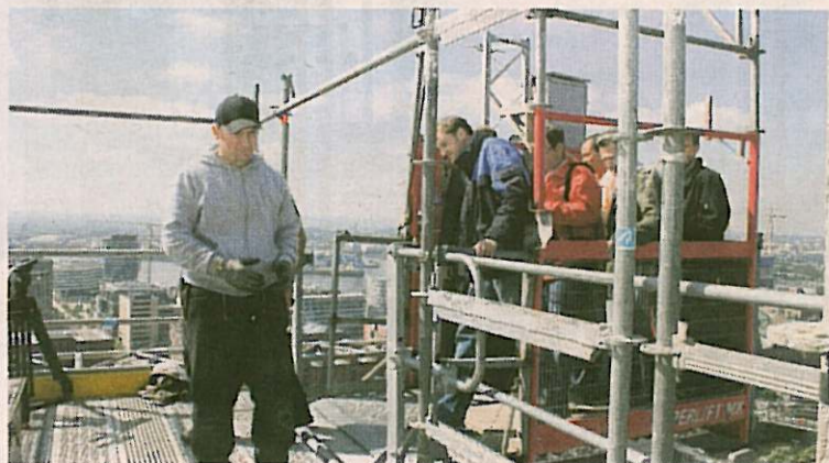
Nichts für Menschen mit Höhenangst: Bauarbeiter Ali Rais bleibt gelassen, während die Journalisten sich vorsichtig aus dem Außenfahrstuhl in 80 Metern Höhe trauen. Er hat keine Angst in solchen Höhen zu arbeiten und sagt ganz pragmatisch: „Das habe ich mir so ausgesucht. Das bringt das Geschäft halt mit sich.“
