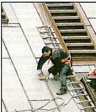
Mehmet Ciplak flickt ein Leck auf einem Speicherstadt-Dach
