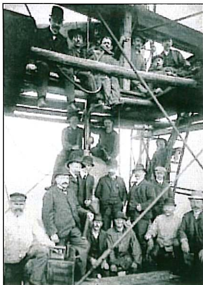
Als die Arbeiter von D.H.W. Schultz noch Hut trugen. Ein Foto von 1906. Damals führten die Beschäftigten Reparaturen auf dem Michel aus. Das Unternehmen ist für seine Arbeiten an Kupferdächern bekannt. Aber auch Sprinkleranlagen kommen aus dem Traditionsbetrieb.
