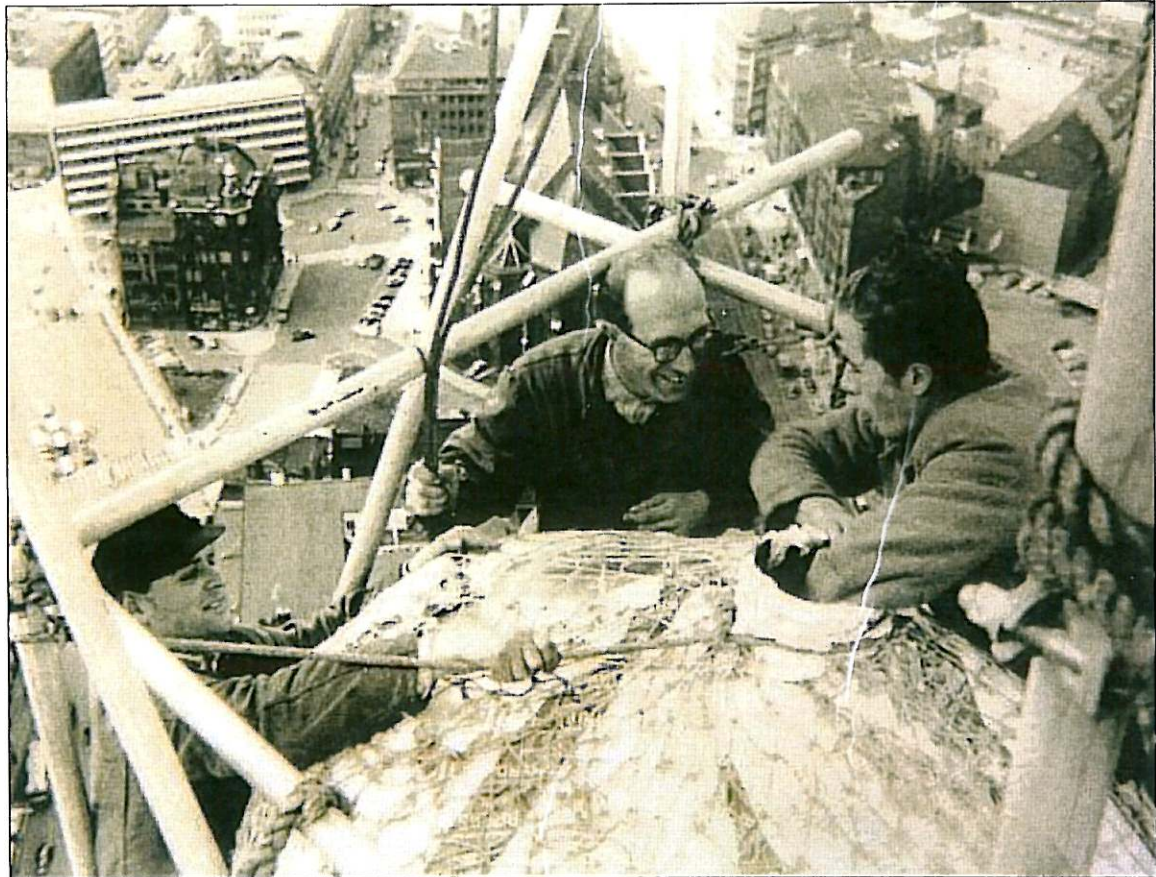
Die Arbeiter von D.H.W. Schultz kennen fast jedes Kirchendach in Hamburg. Hier führen sie um 1960 herum Reparaturarbeiten auf der St.-Jacobi-Kirche aus. Heute hat das Unternehmen noch 32 Mitarbeiter und erzielt einen Jahresumsatz von etwa vier Millionen Euro.
